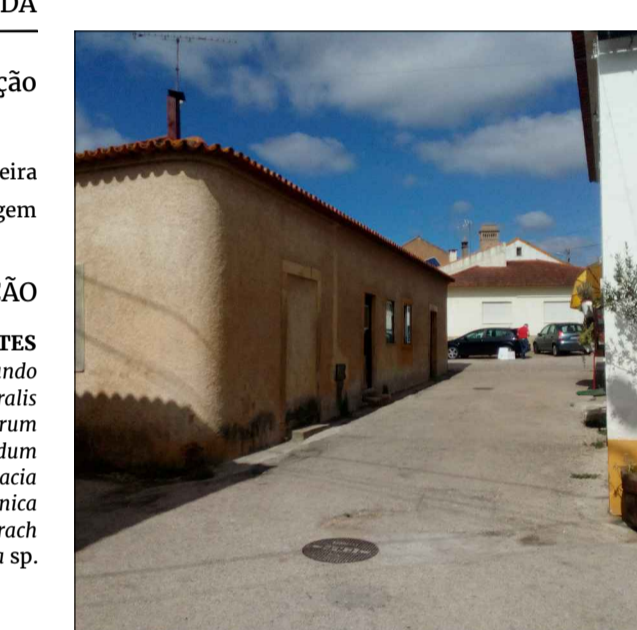
14. Travessa em betuminoso entre a rua do Pombal e Largo do S.C.O.C.S.
