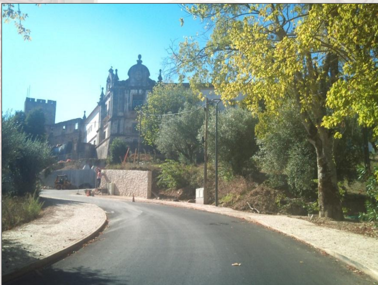
Obras da Envolvente ao Convento de Cristo
